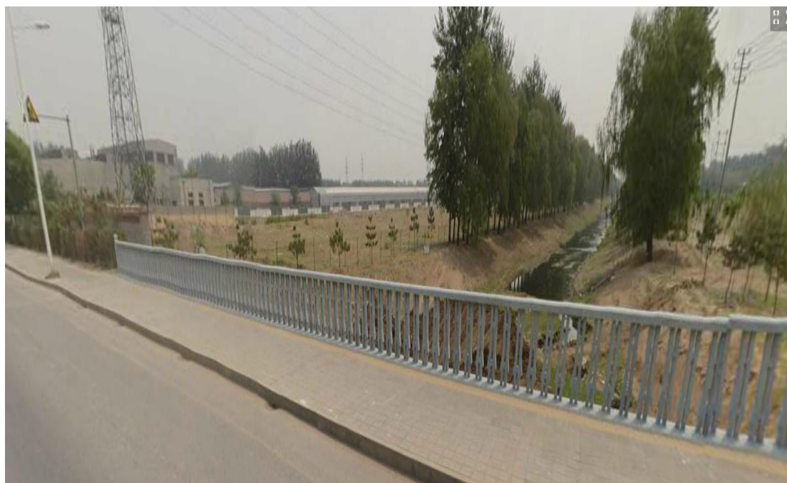
图 4 天堂河桥梁实景图
