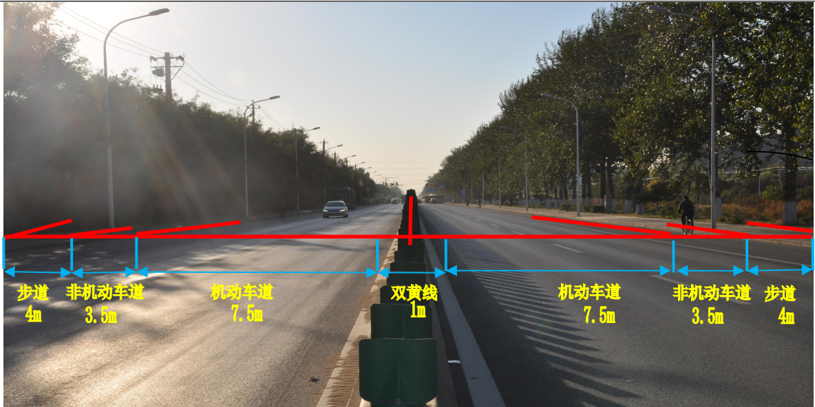
图3 道路横断面实景图（明川大街~京开路段）
