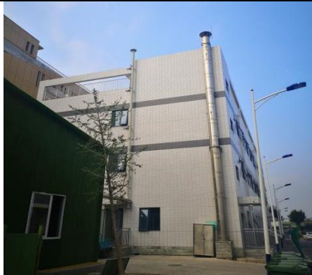
宿舍楼及锅炉房排气筒
