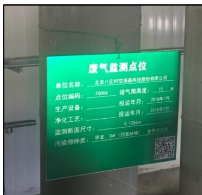
图 25 生产有机废气排放口标识牌
