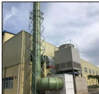
图 13 合成五通风尾气处理设备
