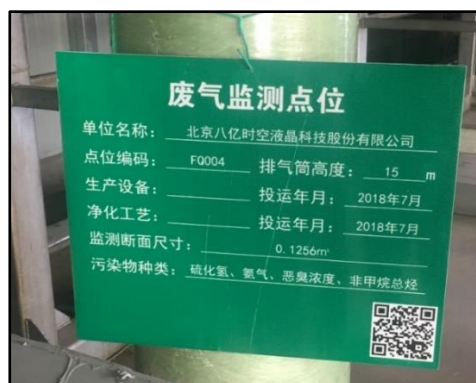
图 24 污水处理站废气排放口标识牌
