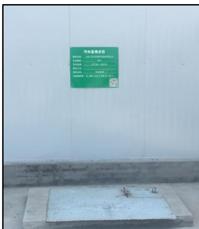
图 11 废水排放口标识牌
