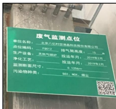
图 22 热水锅炉废气排放口标识牌
